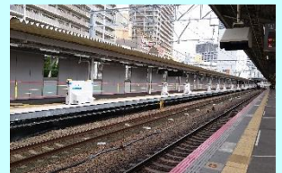
④整備された新型ホームドア
