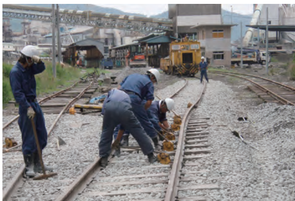
写真 2.11.4 社員による線路復旧
