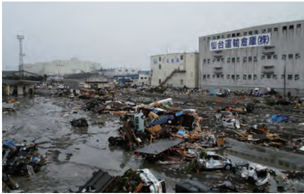
写真 2.12.1 被災直後の仙台港駅構内
