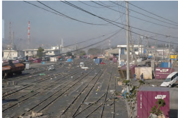
写真 2.13.2 地震・津波で被災した小名浜駅構内
