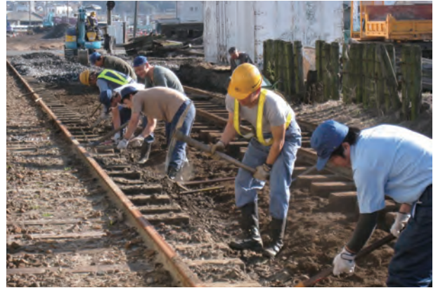
写真 2.13.4 社員による軌道復旧工事
