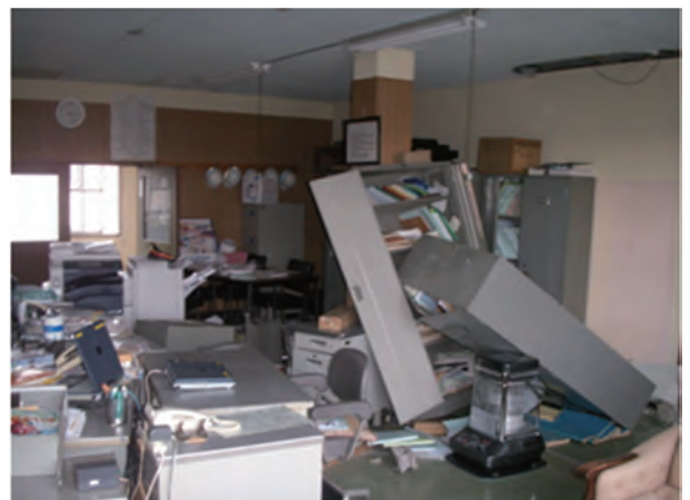
写真2.8.1 散乱した本社事務所
