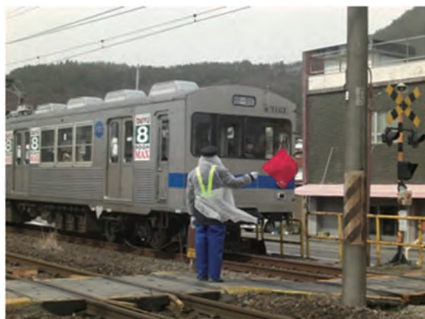
写真 2.8.3 屋敷下踏切での踏切防護
