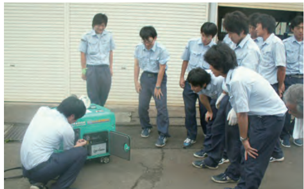
写真 2.9.6 ディーゼル発電機の取り扱い訓練
