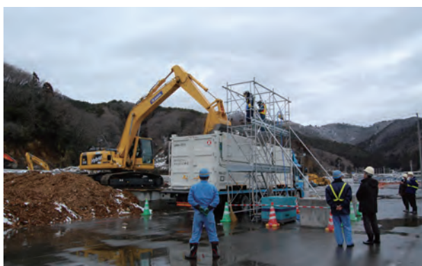
写真 2.9.5 コンテナで災害廃棄物輸送
