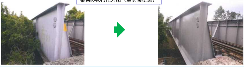
橋梁の老朽化対策（重防食塗装）
