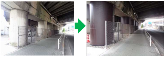
高架橋の耐震補強（鋼板巻き）
