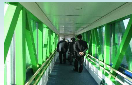
(小型機対応旅客搭乗橋内通路)
