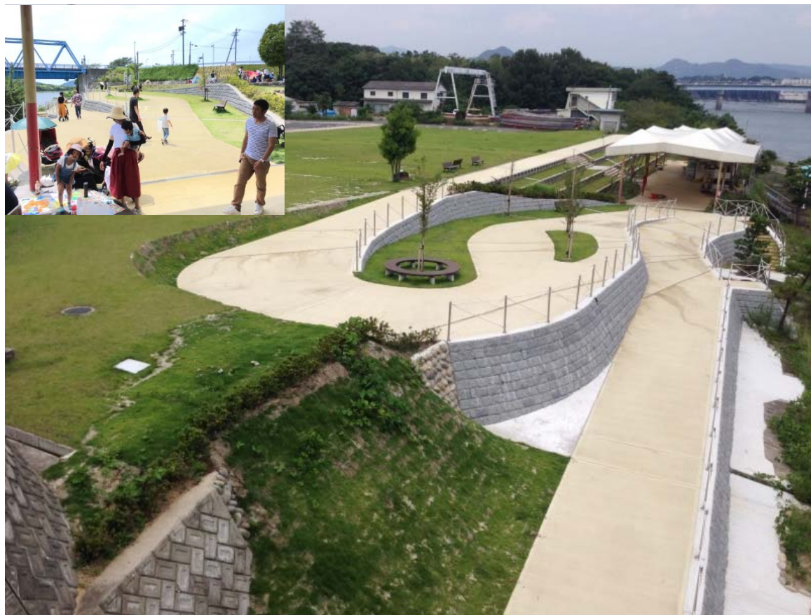
緩傾斜スロープの整備
