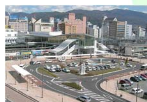
交通結節点整備
