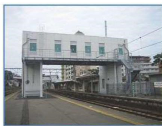
エレベーター
