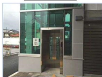
エレベーター
