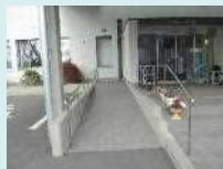
出入口の段差解消 事業費：30万円程度
