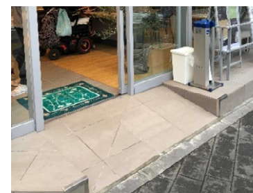
スロープの設置
