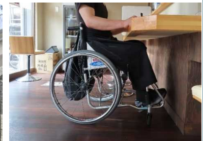
ローカウンターの設置
