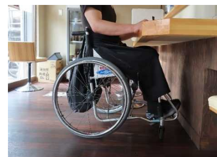
ローカウンターの設置
