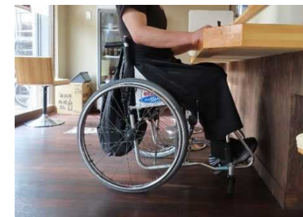
ローカウンターを設置
