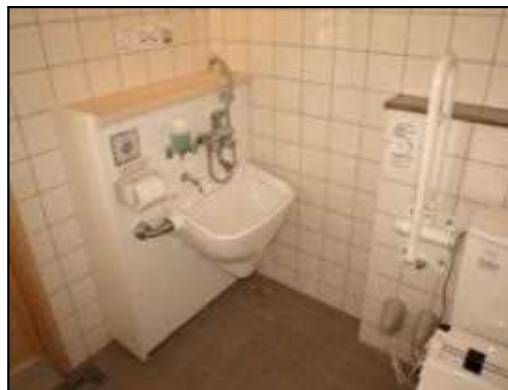
バリアフリートイレの整備
