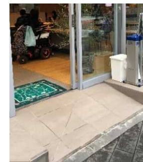
スロープの設置
