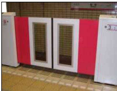
ホームドアの設置
