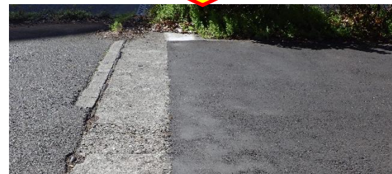
【新御園橋交差点付近】
