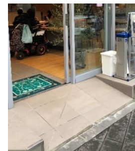
スロープの設置
