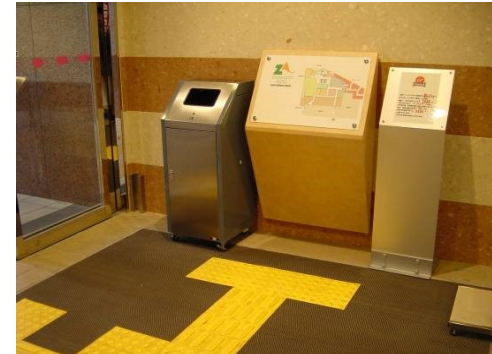
点字ブロック、点字案内板の設置
