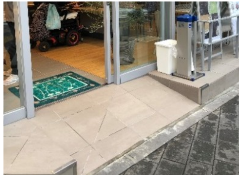
スロープの設置
