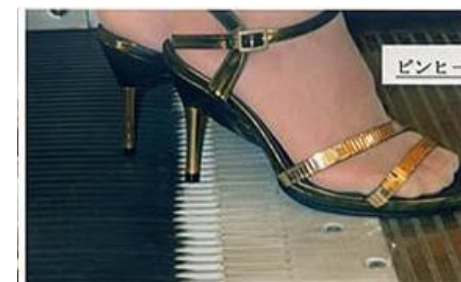
段差のない動く歩道 (搭乗待合エリア内)
