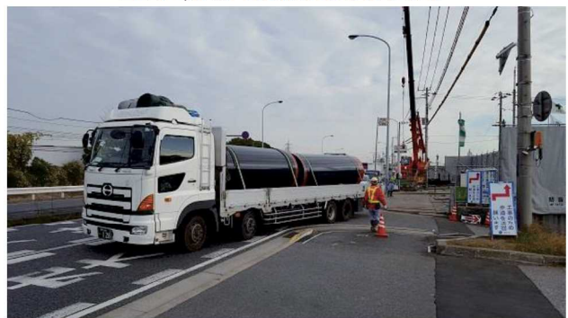
工事現場への納入時の状況
