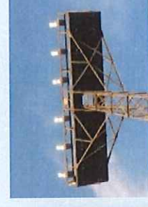
構内照明設備のLED化
