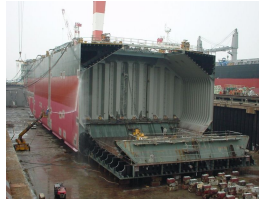
船体断面(建造中)
