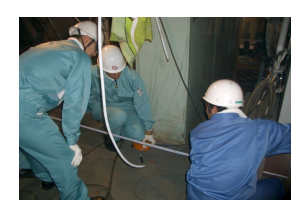
上部構造物の計測
