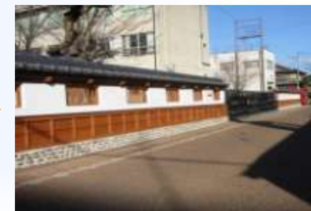
門扉の修景(愛知県犬山市)
