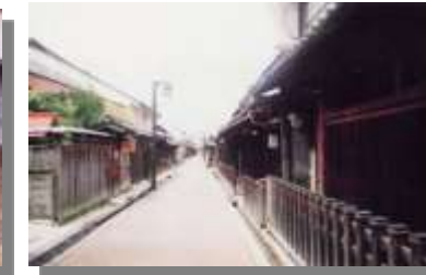
道路美装化・電線地中化・街路灯整備等
