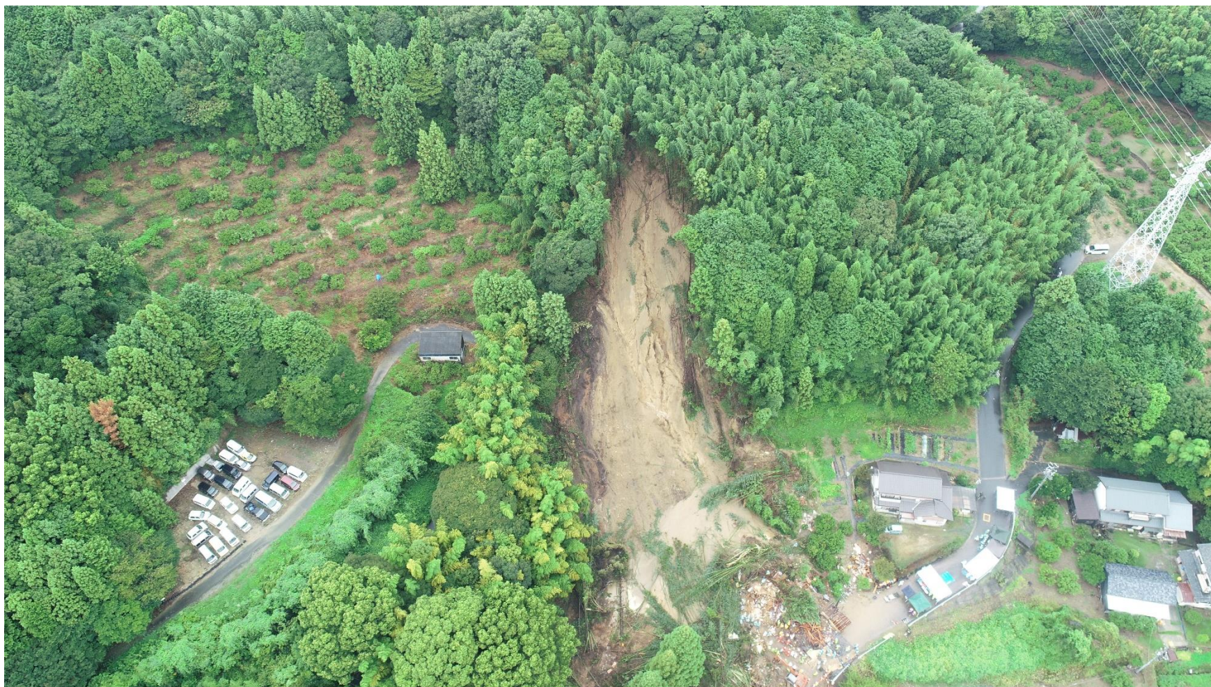
土砂災害の状況(令和8年8月28撮影)
