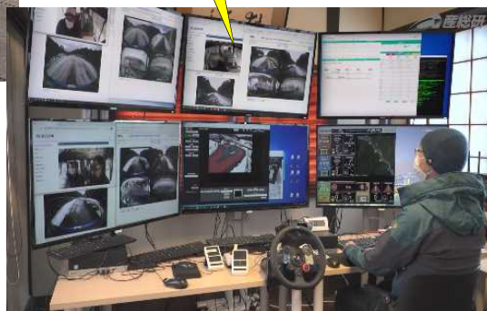
遠隔監視・操作室
