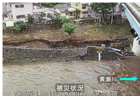
黄瀬川左岸2.6k付近
