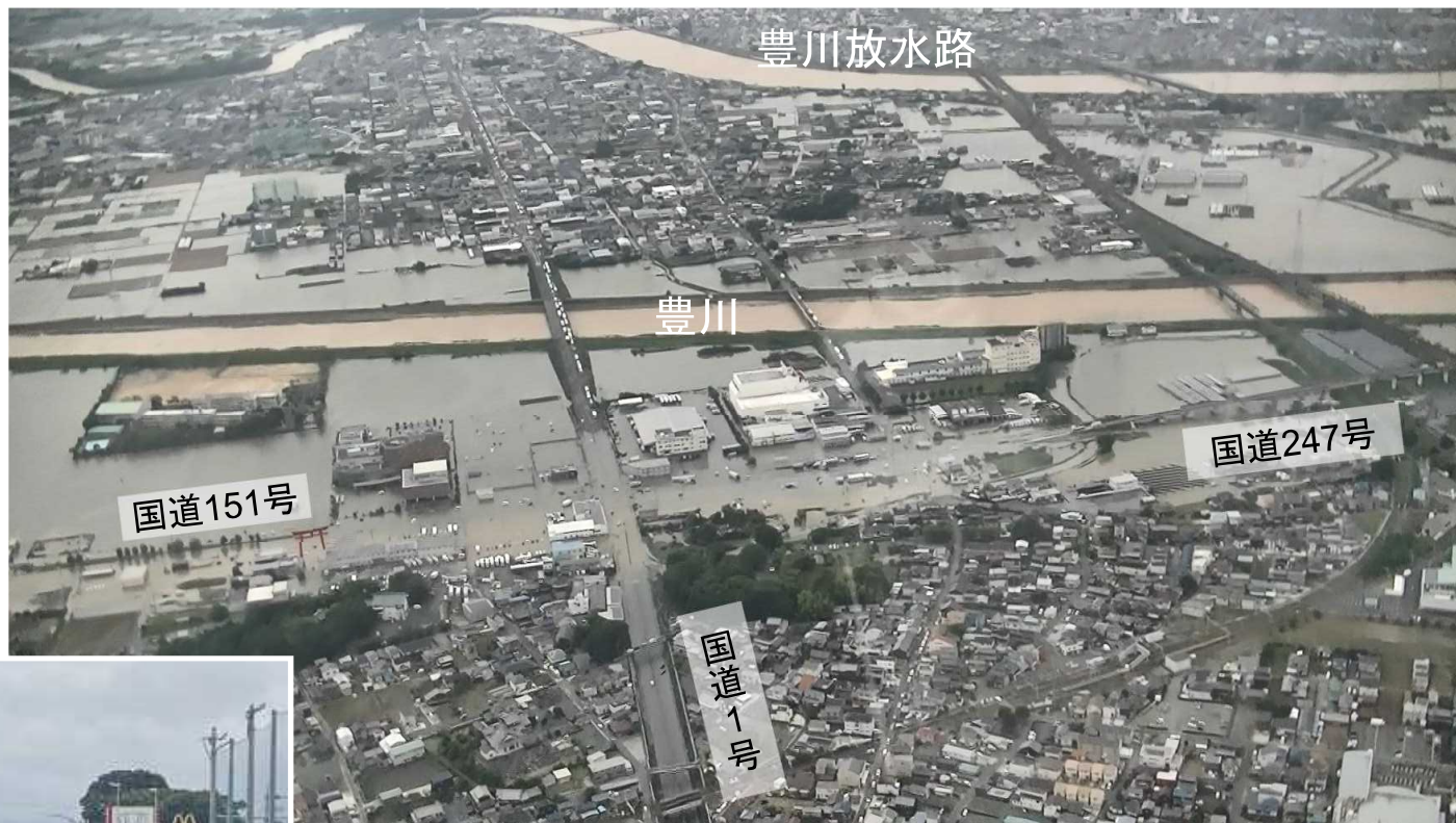
豊橋市 市街地付近の浸水状況
