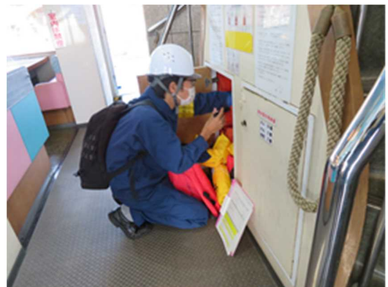
過去の点検の様子（救命胴衣の確認）
