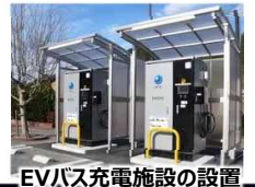
EVバス充電施設の設置
