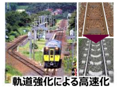
軌道強化による高速化
