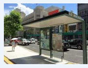
・多言語バスロケーションシステムの設置
