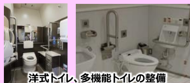
洋式トイレ、多機能トイレの整備
