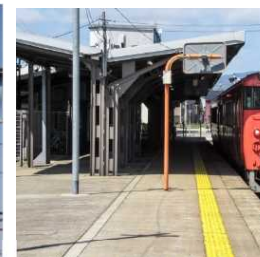
駅舎・ホーム改修
