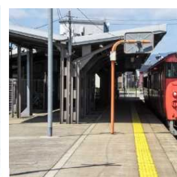
駅舎・ホーム改修
