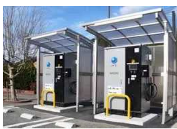
EVバス充電施設の設置
