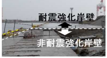
耐震強化岸壁の整備
