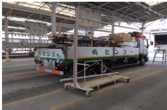
(養生シート掛け作業)
