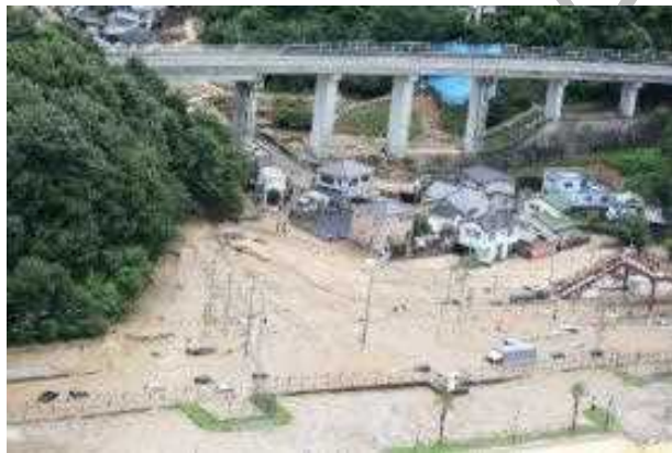
水尻駅構内 土砂流入
