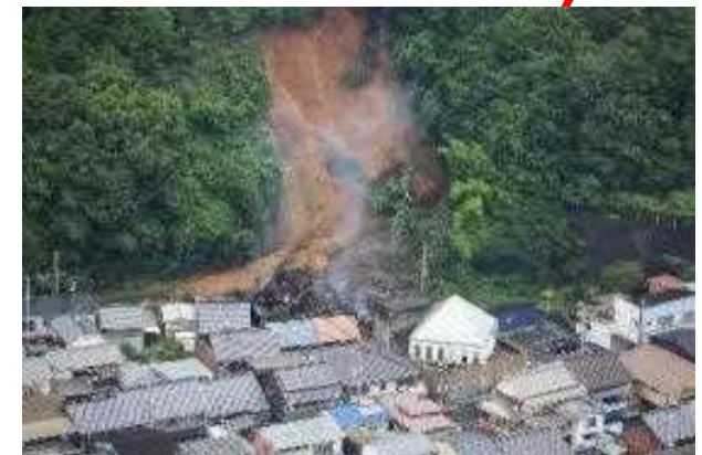
安芸幸崎駅構内 土砂流出
