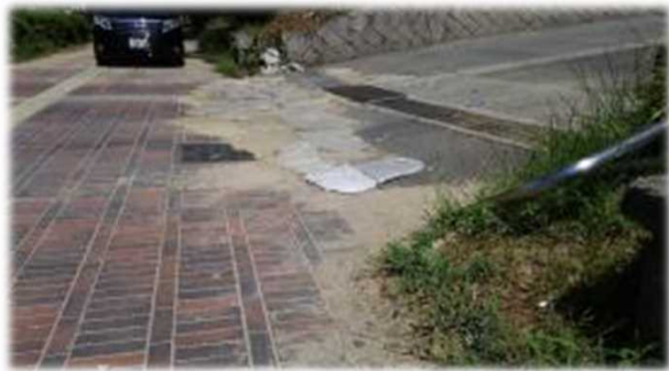
呉市入船山駐車場出入り口（段差解消）
