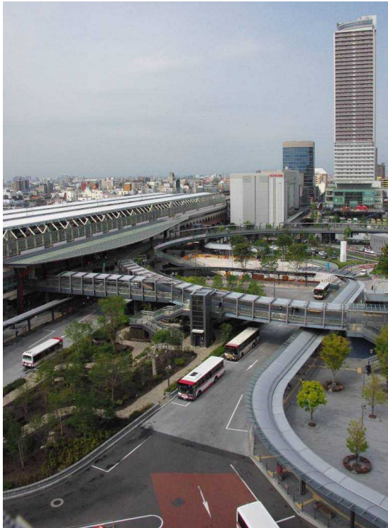
【岐阜駅北口駅前広場】
