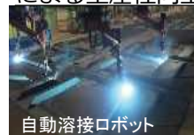
自動溶接ロボット
