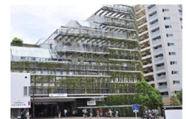
大岡山駅(駅外観)
