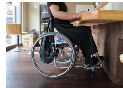
ローカウンターの設置
