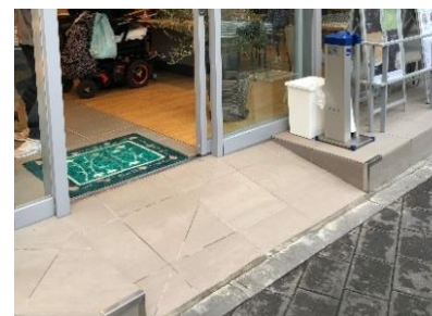
スロープの設置
