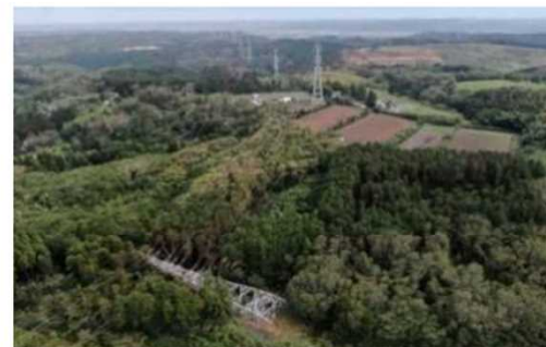
台風15号により倒壊した鉄塔
