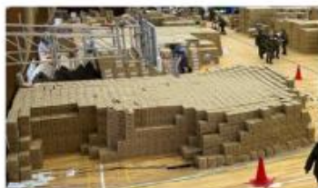
床が抜け落ちた体育館
