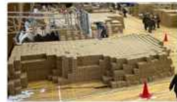
床が抜け落ちた体育館
