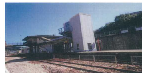
【整備後（エレベーター等設置）】
