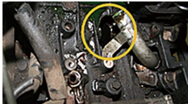
<エンジンの破損状況>
