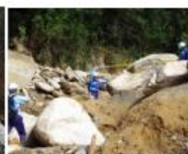
土砂災害被害状況の調査
