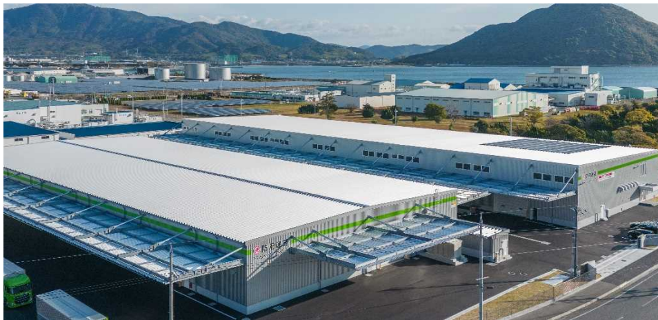
ZEB(省エネ性能)の認証を受けたテクノタウン物流センター
