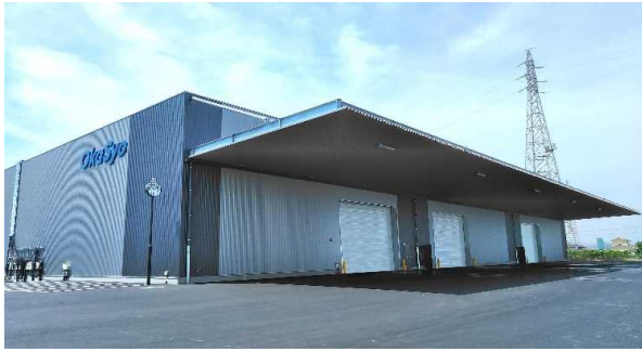
特定流通業務施設(第二倉庫)
