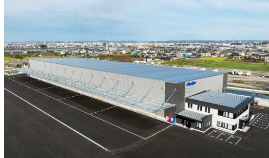
特定流通業務施設(第四倉庫)
