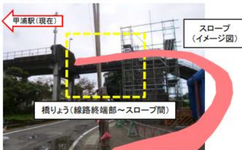
橋りょう(線路終端部~スロープ間)の施工状況
