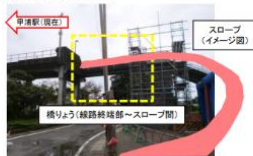
橋りょう(線路終端部~スロープ間)の施工状況
