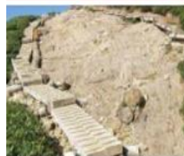
自然保護のための遊歩道の整備
