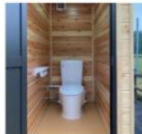
災害用トイレの整備
