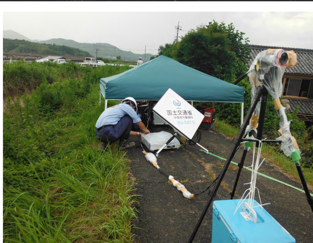
衛星通信装置(Ku-SAT II) によるリアルタイム監視
