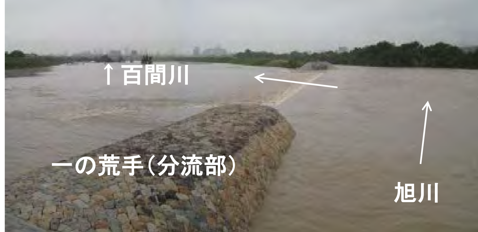
旭川放水路(百間川) 分流状況(7/6(金))
