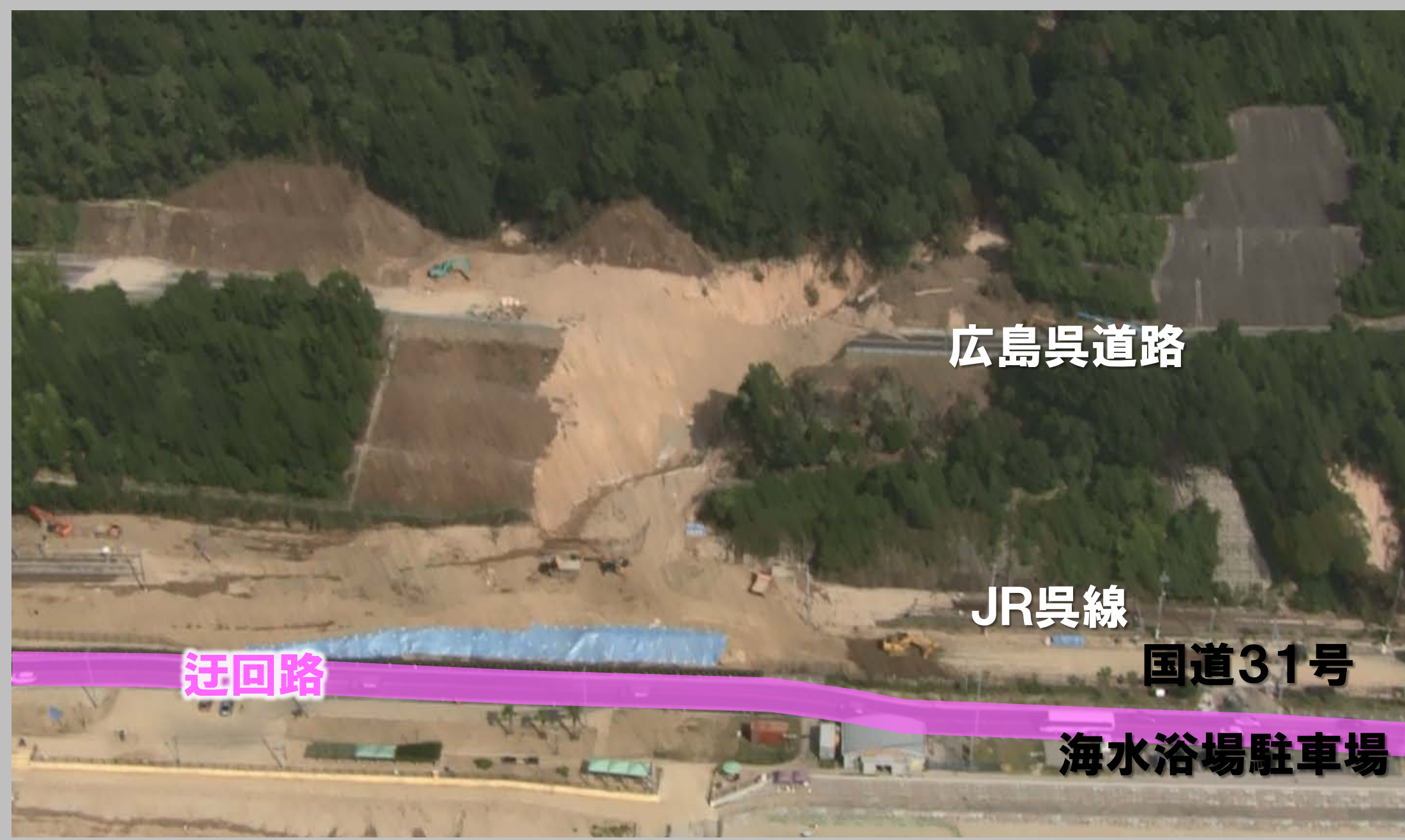
■迂回路整備後(平成30年7月12日撮影)
